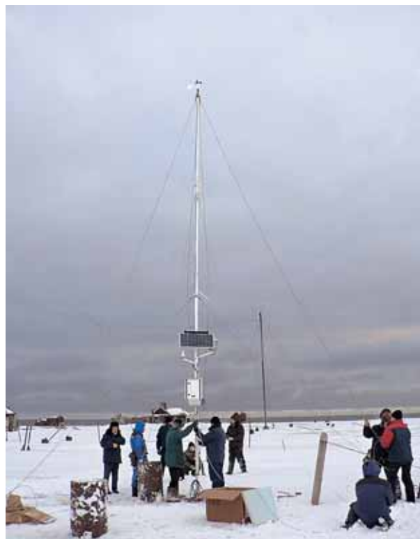
Установка автоматической метеорологической станции на о. Русский
