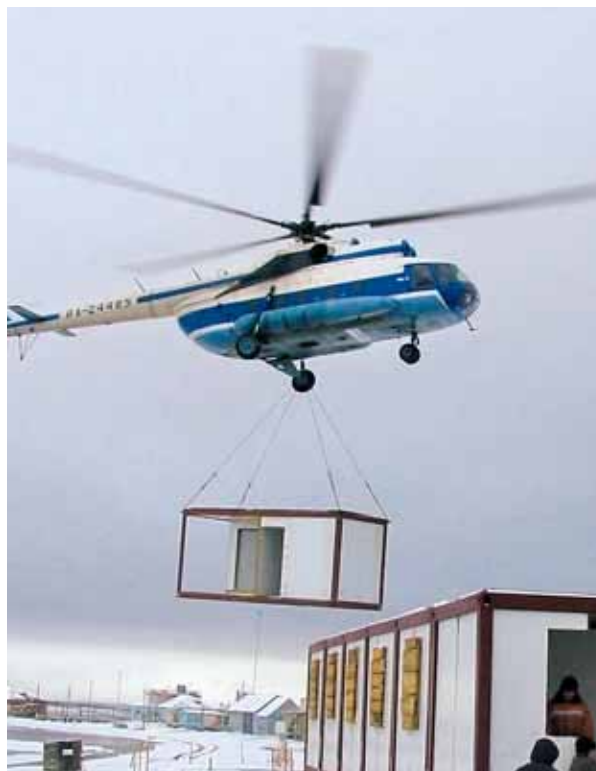
Момент, ставший историей. Монтаж нового служебно-жилого модуля на ОГМС им. Э.Т. Кренкеля (о. Хейса, ЗФИ)
