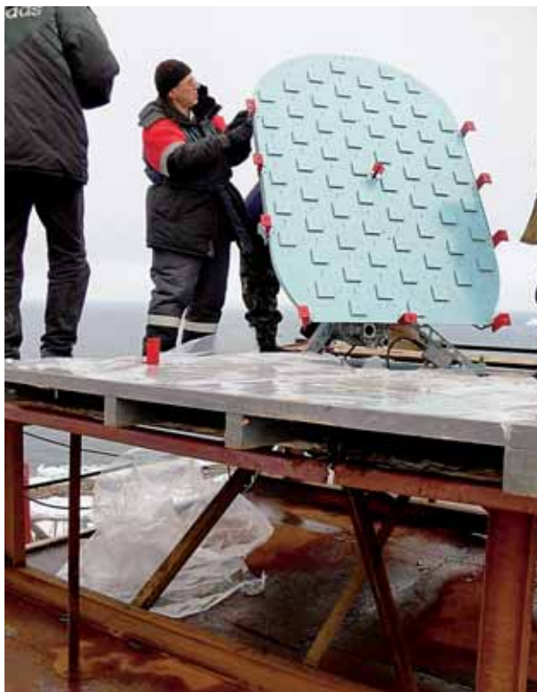
Монтаж метеорологического аэрологического радиолокационного вычислительного комплекса (МАРЛ) на ОГМС им. Э. Т. Кренкеля
