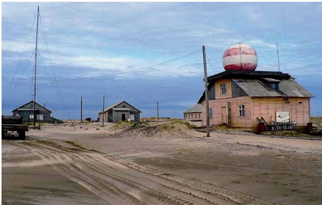
Комплекс сооружений полярной станции Шойна на полуострове Канин Нос
